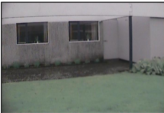
Billede 3: Luftvarmen under gulvet medfører desværre lidt spild gennem soklen. (De lyse områder forneden)
