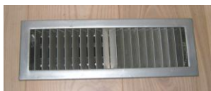
Indsugnings-gulvrist, som kan åbnes og lukkes
