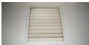
Udsugningsrist i stuen
